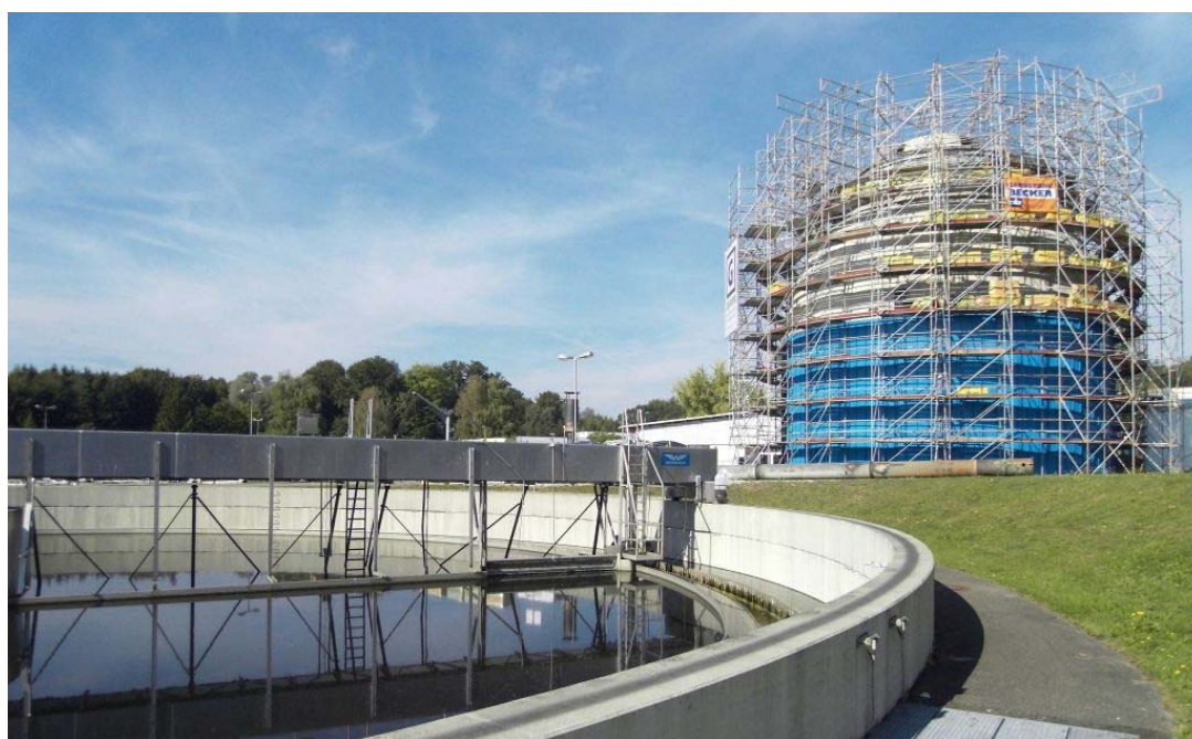
Faulbehälter mit Nachklärbecken
